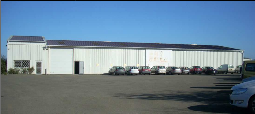
Façade ' Entrée bureaux' du bâtiment
