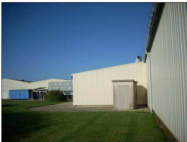
Façade Bâtiment coté cabine à vernis et dépoussiéreur
